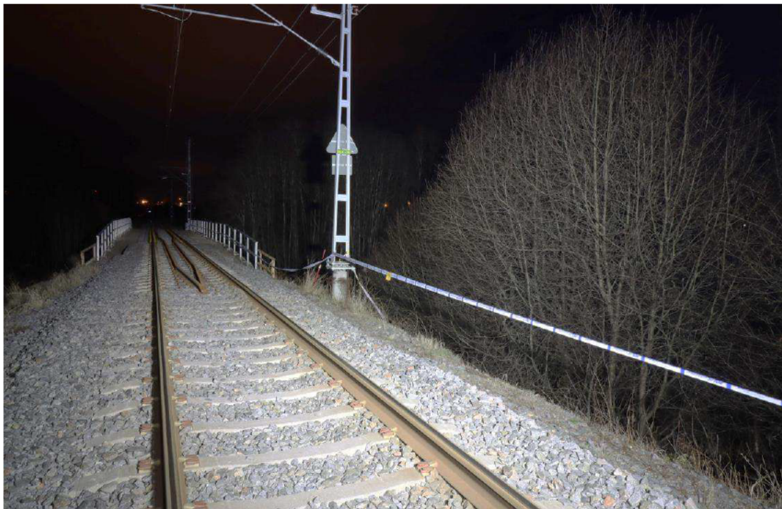
Figur 6. Foto från järnvägsspåret i östlig riktning. Undersökningsplatsen var söder om spåret bakom avspärrningsbanden till höger i bild. Det undersökta området sträckte sig ned till strandkanten.
